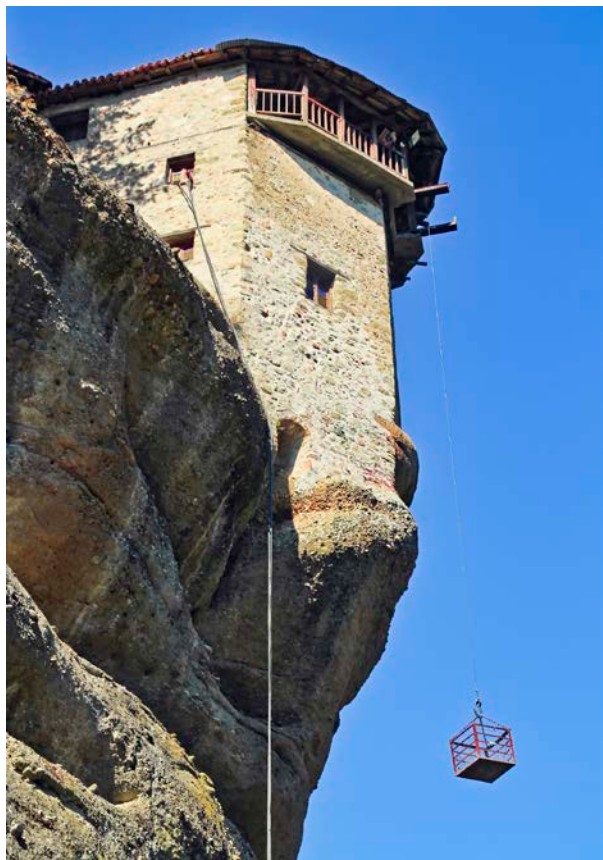
图 6-3 瓦拉姆修道院的吊篮
